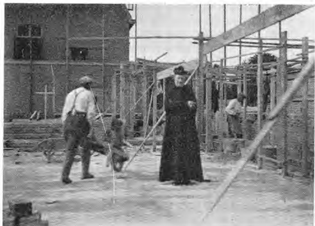
De nieuwe kapel in aanbouw.
